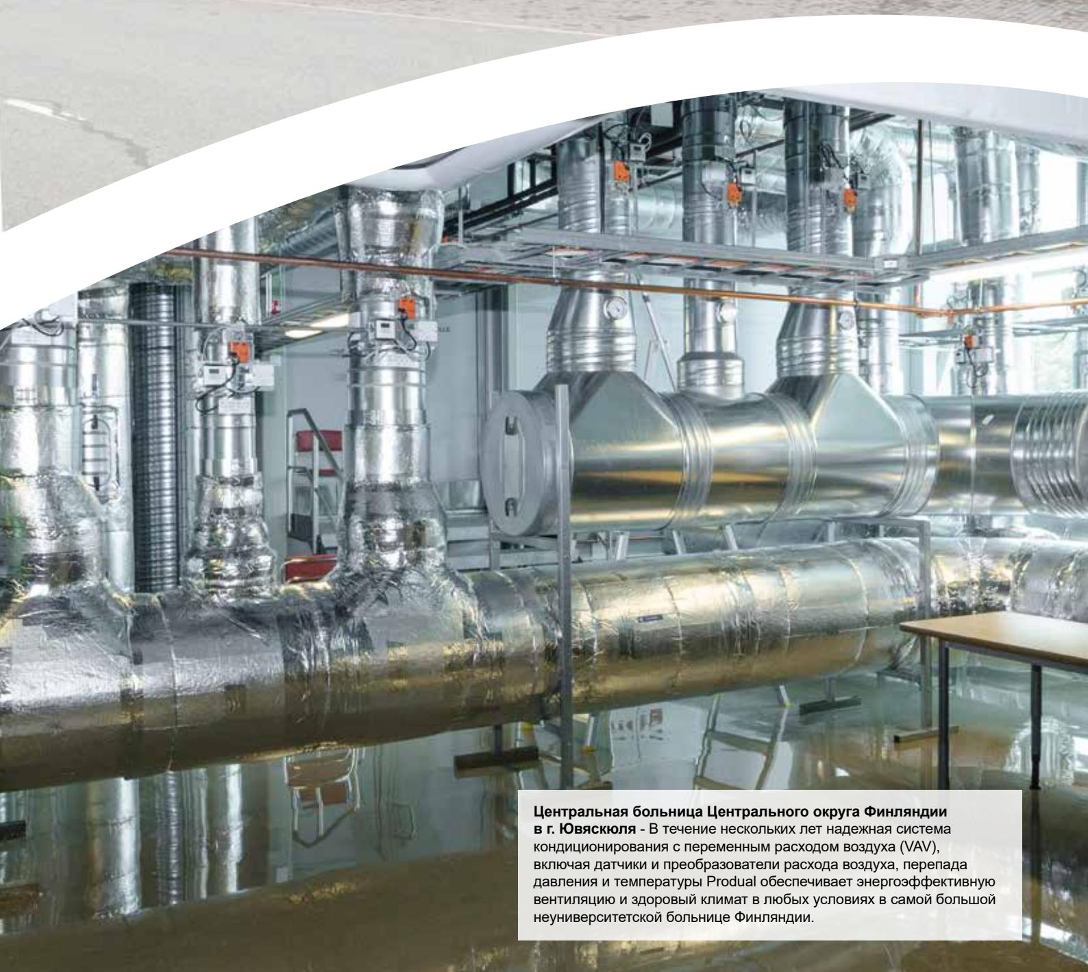
**Центральная больница Центрального округа Финляндии в г. Ювяскюля** - В течение нескольких лет надежная система кондиционирования с переменным расходом воздуха (VAV), включая датчики и преобразователи расхода воздуха, перепада давления и температуры Produal обеспечивает энергоэффективную вентиляцию и здоровый климат в любых условиях в самой большой неуниверситетской больнице Финляндии.
