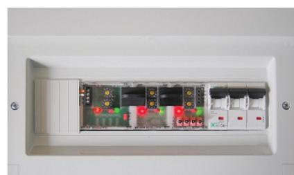
Рис. 3. Модули Modbus IO, установленные в электрическом щитке
